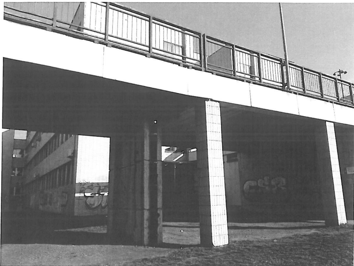
Obr.1 - Pohľad na dva rozličné konštrukčné systémy lávky (KD 70 vľavo a MSRP vpravo)
